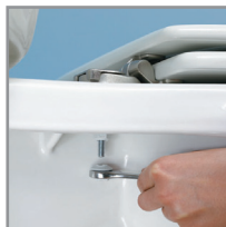
Desprenda la parte inferior del perno.
