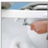
Desprenda la parte inferior del perno.
