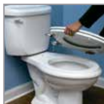
Instale el asiento en el sanitario.
