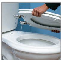
Instale el asiento en el sanitario.
