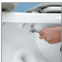
Desprenda la parte inferior del perno.
